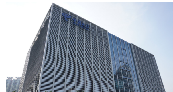
位于广东省广州市海珠区的中国电信广州云计算数据中心是华南以及粤港澳大湾区重要的网络和数据节点之一，2019 年 11 月 19 日，新建的沙溪 IDC 机房交付使用
