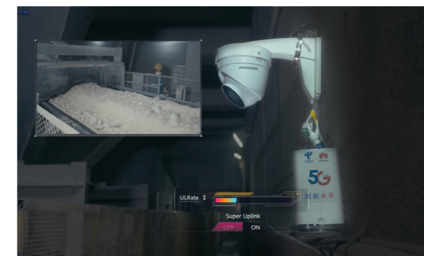
海螺集团全椒水泥厂通过 5G 实现对生产的高清视频监控
