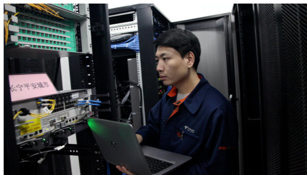
2019 年 12 月 19 日,化树明在机房调测专网链路
