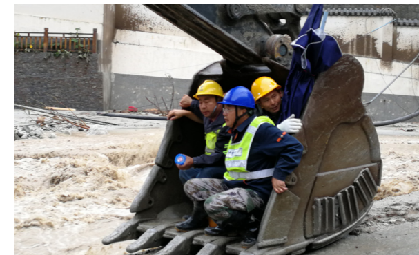
2019 年 8 月 20 日，四川省阿坝藏族羌族自治州汶川县、理县等地发生洪水及泥石流灾害，四川公司迅速恢复受灾地区的通信业务，图为 21 日抢险人员通过挖掘机过河抢修受损的通信设施
