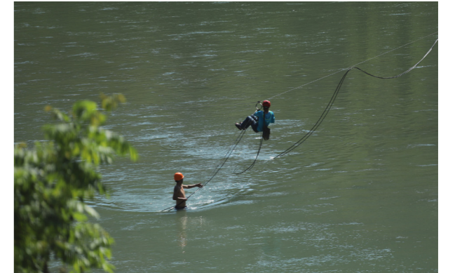
2019 年 8 月 11 日，因“利奇马”台风影响，浙江省台州市仙居县淡竹乡尚仁大桥存在坍塌风险不能通行，抢修人员搭起高空滑索涉水作业
